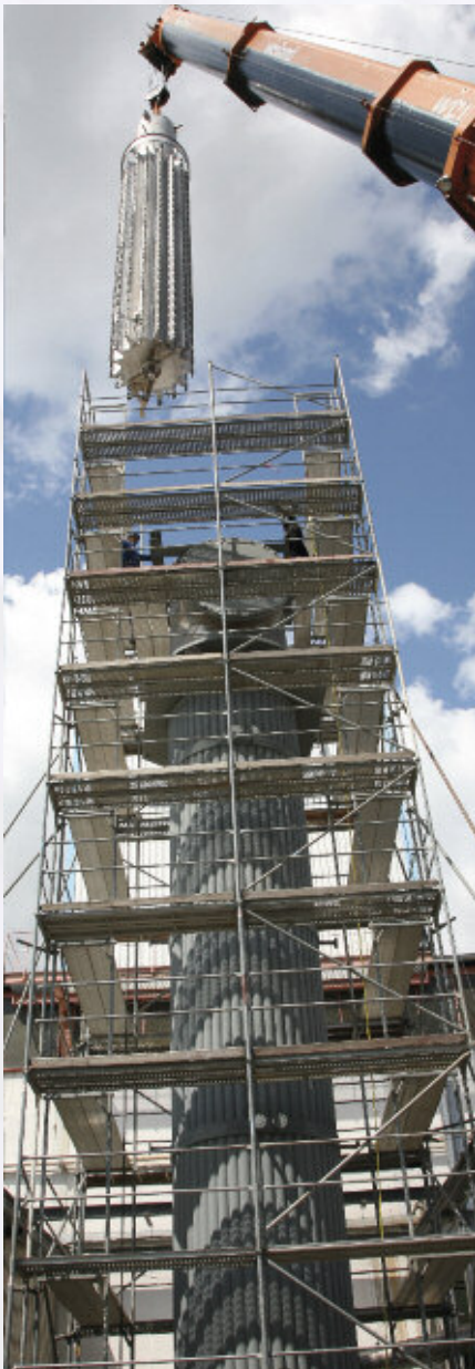
CP-Trockner bei der Montage
