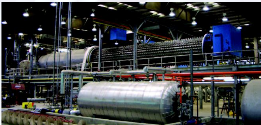
Secador de lodos com rotor puxado
