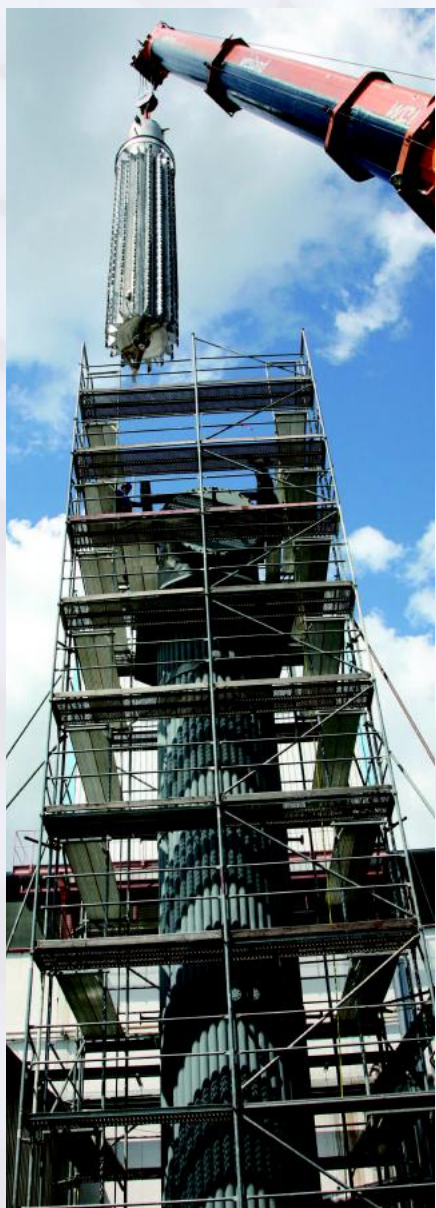
Montagem do secador CP
