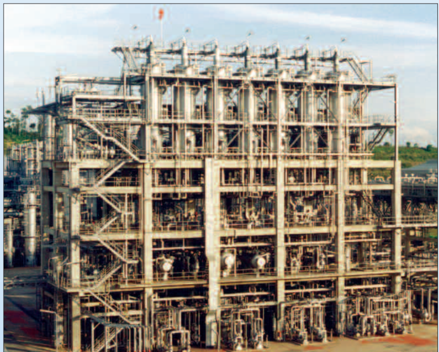
Für die Produktion von Soft- und Hartwachsen lieferte Buss-SMS-Canzler an einen namhaften Hersteller in Südostasien die weltweit größte mehrstufige Kurzwegverdampferanlage.
